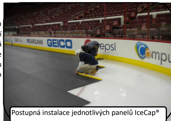
IceCap® Pro panely mohou být použity pro přeměnu hokejové arény v koncertní sál
